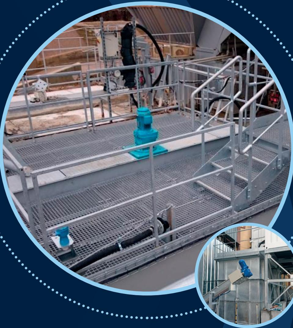
**Le bassin proposé est métallique, hors sol, assemblé ou pré-assemblé, en fonction de ses dimensions. Il est généralement de forme carrée, afin d'améliorer le brassage de l'effluent, dans le cas d'un bassin agité.**
